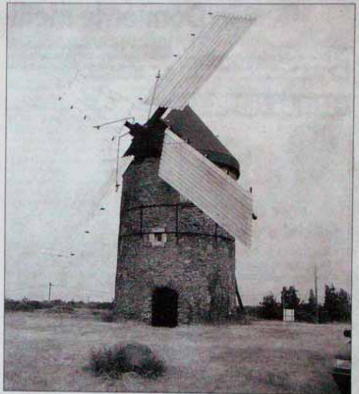
Le Moulin de la Roche à la Possonnière (Anjou), avec ses ailes à planches, système Berton, ouvertes.
