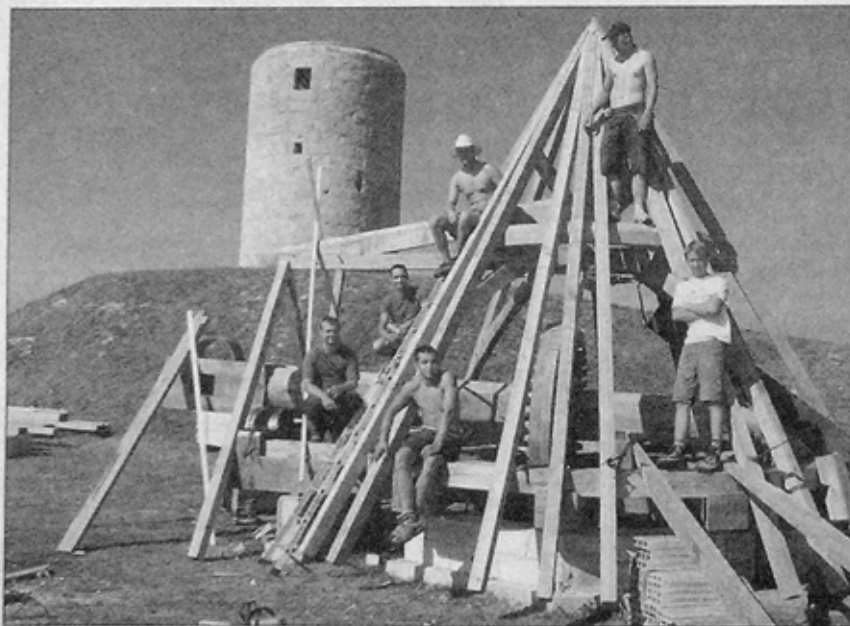
La restauration du moulin à vent de Grateloup par les Compagnons du tour de France. Sur la coiffe : Jérôme Talenton, Clément Colinet, Benoît Pessin, Julien Nies et Nathale Chipeaux.
